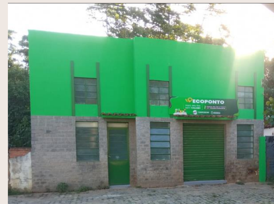
Ecoponto 5 - bairro Cristo Rei, 1º distrito
